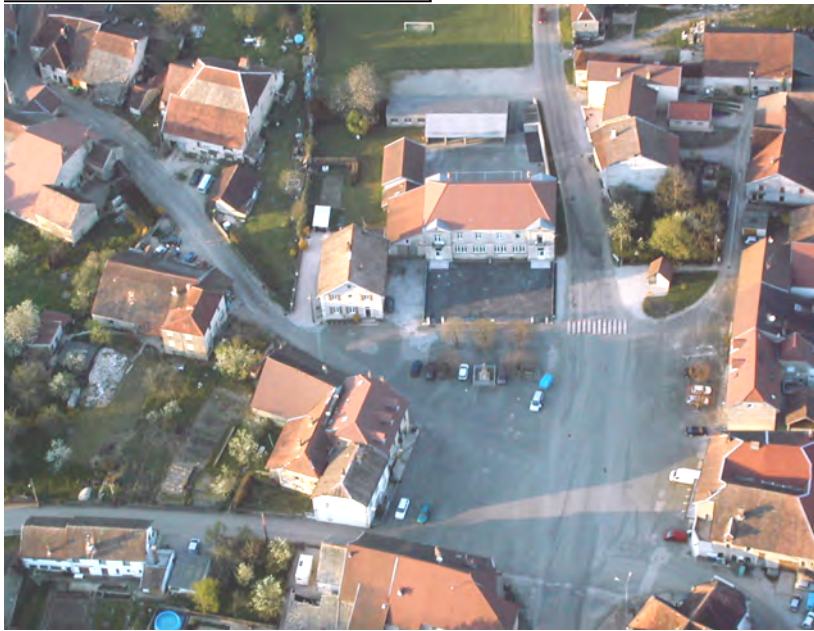
La place de LIESLE avant travaux
